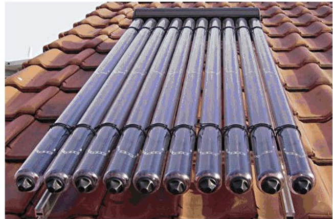
Figure 3 : capteurs solaires thermiques Gauche : tube sous vide ; Droite : chauffe-eau solaire individuel
